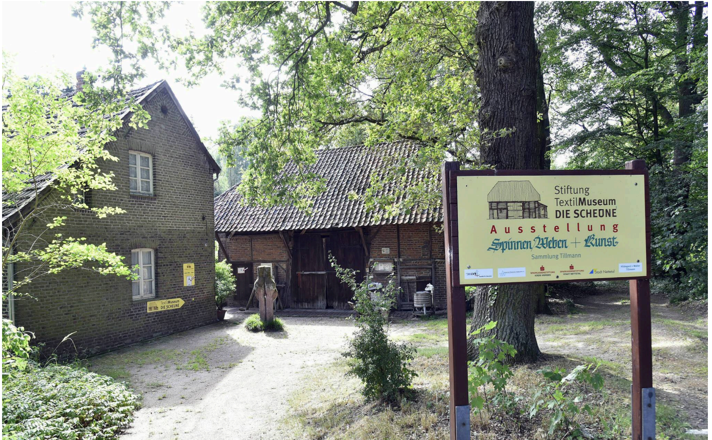
Das Museumsgebäude zu renovieren, würde nach Erkenntnissen der Stadt hohe Kosten verursachen.
